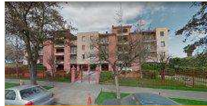
Conjunto Residencial Goycolea, La Cisterna.
